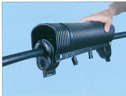
② 本体を端面板に合わせてかぶせる。
