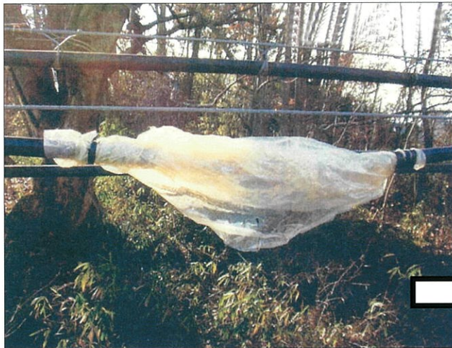
ビニールによる仮修理
