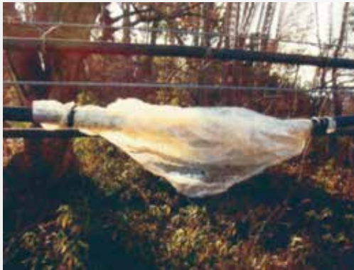
(従来) ビニールによる仮修理
