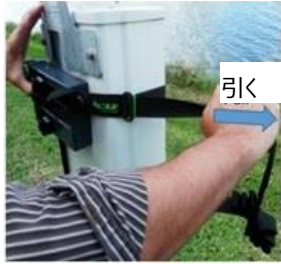
ウェビングストラップを引っ張り、アンテナに固定します。
