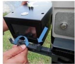
ストラップクランプを固定したら、RFアライナーを取り付けて位置合わせを行います。設定完了後、RFをアンテナから取り外す。
