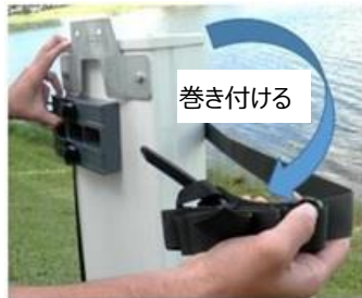
ストラップクランプ本体をアンテナの端の上部にセットしてウェビングストラップをアンテナに巻きつけます。
